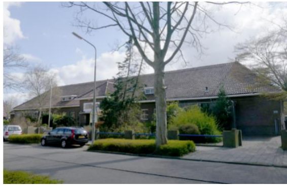
Hoofdgebouw voormalige basisschool
