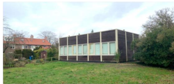
Bijgebouw en terrein behorend bij het plangebied
