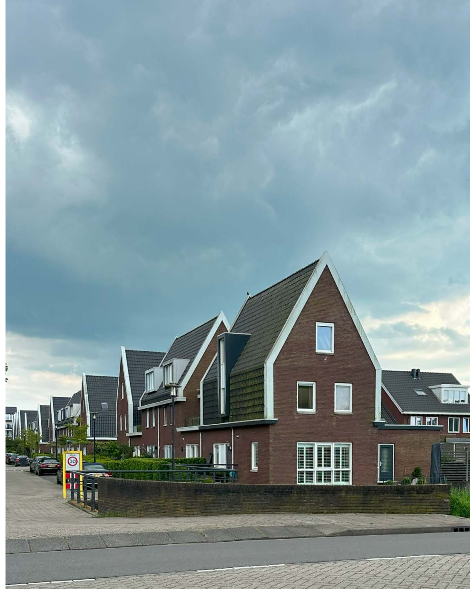
voorbeeld: grondgebonden woningen in Kudelstaart
